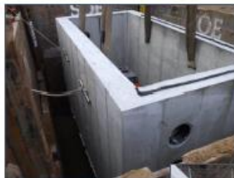
Instalación de la bóveda
