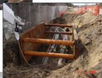
Instalación de conductos
