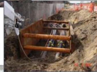
Conduit Installation
